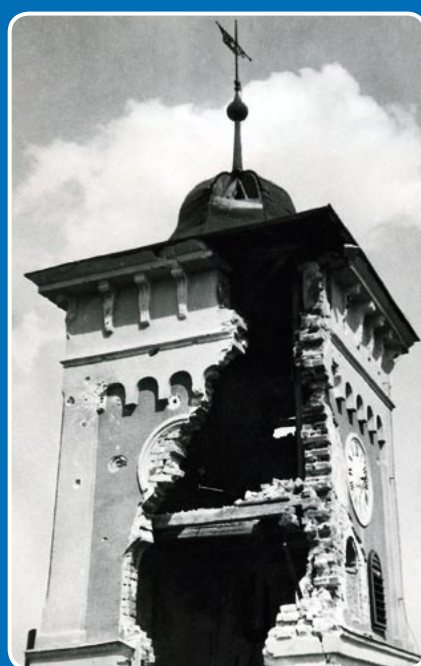
Poškozená věž radnice, 1945 Damaged town hall tower, 1945 Beschädigter Rathausurm, 1945
