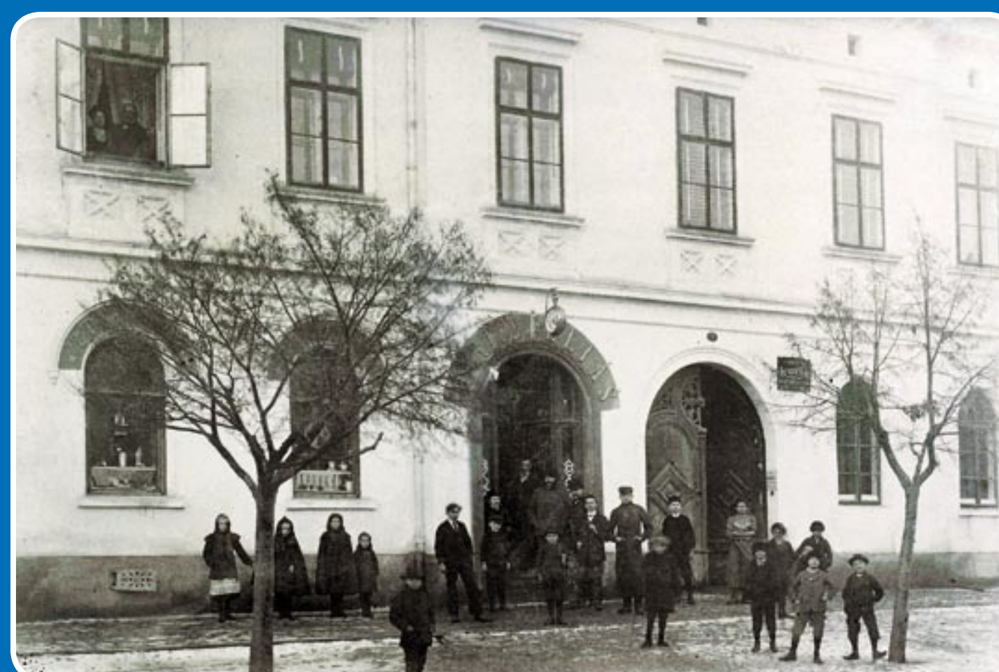
Budovy na náměstí * Buildings on the square * Gebäude auf dem Stadtplatz
