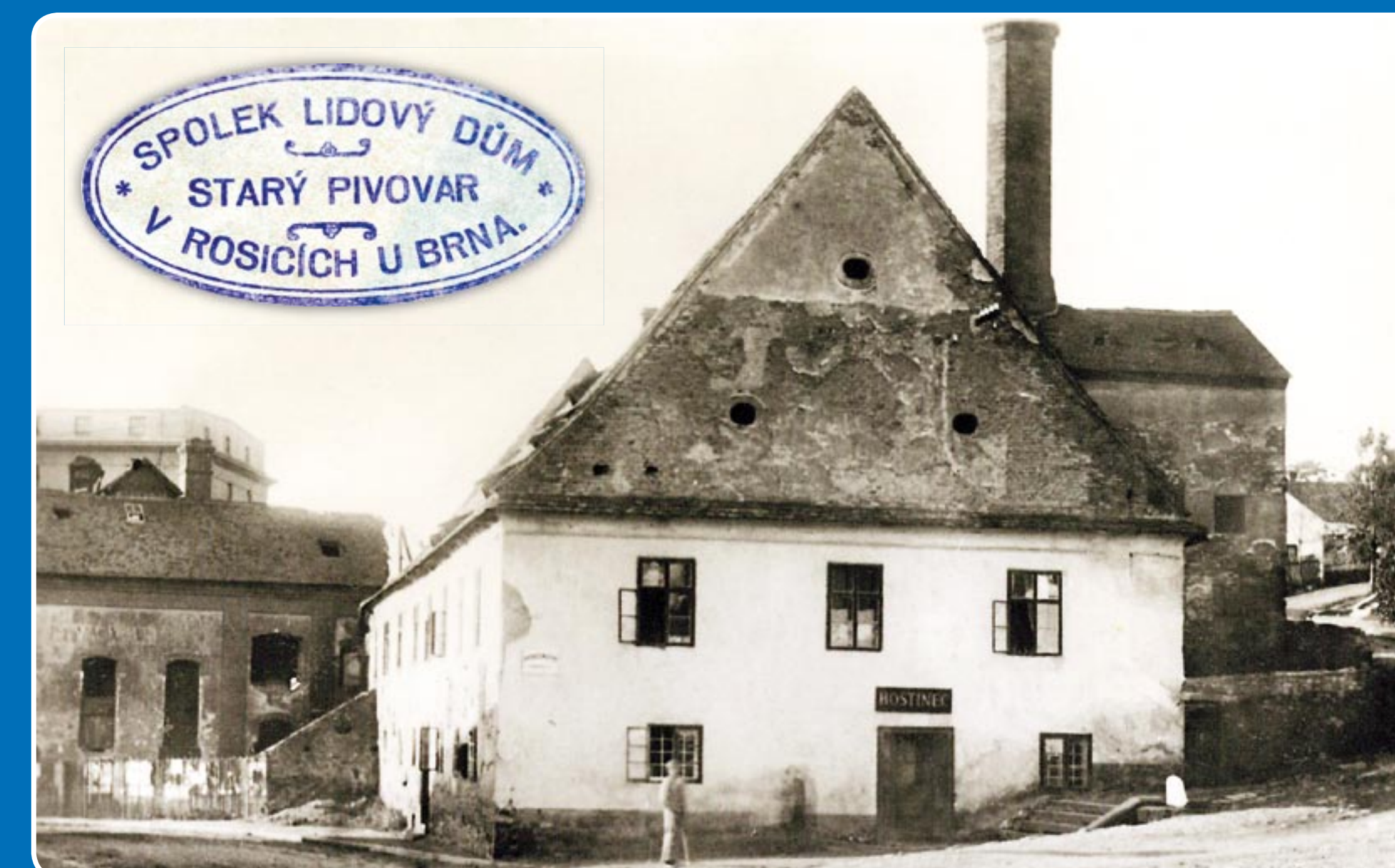
Pivovar před demolicí, 1934 * Brewery before demolition, 1934 * Brauerei vor Demolierung, 1934
