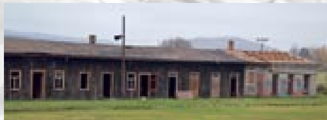
Bourání staré loděnice.
