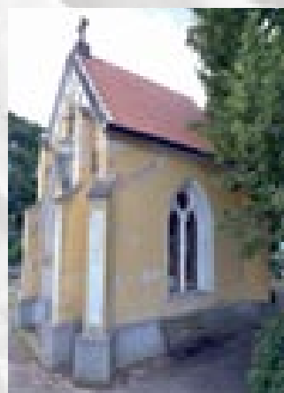
Oprava kaple na hřbitově.
