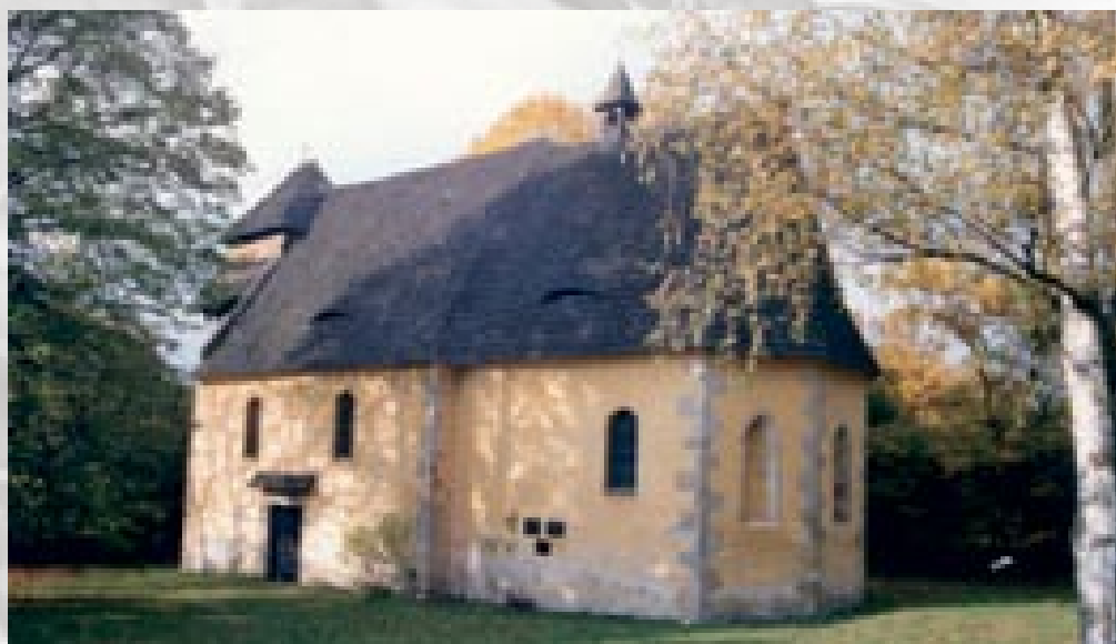
Vícov před opravami.
