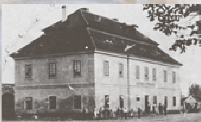
3. Snímek hostince U Černého orla někdy z počátku 20. století. Vlevo vidíme vrata do hospodského dvora (stejná byla i na protilehlé straně). Vzádu malý domek pohořského mýta.
