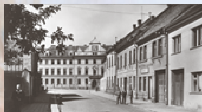
4. Červenková ulice někdy v polovině 20. století. Na snímku vpravo v popředí č. p. 122 kameníka Kripnera, dále č. p. 121 Františka Zaidlera, který zde provozoval chemickou čistírnu. V tomto původně přízemním domku vyrůstal František Červenka, po němž nese ulice své jméno. Následuje č. p. 120 s knihtiskárnou Antonína Ouřady. Vedle něho dům židovské obce č. p. 119, za ním č. p. 757 s kadeřnictvím Karla Voláka. Uliční řadu uzavírá nárožní dům č. p. 118 Josefa Stacha za koloniálem.
