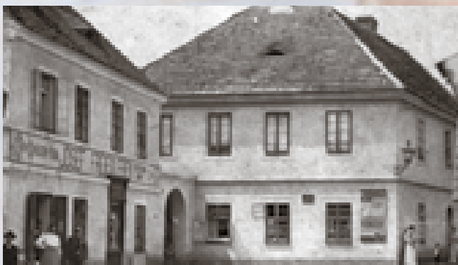
3. Levá strana Červenkovy ulice při pohledu od náměstí kolem roku 1900. V popředí č. p. 115 s vyznačenou firmou majitele domu, obuvníka Josefa Freislebena. V té době u něho bydlel v podnájmu první přeštický rabín Leopold Singer, než byl v roce 1913 naproti vybudován rabínský dům č. p. 119 a synagoga v Husově ulici. Za ním dům č. p. 116, zužující Červenkovu ulici a z toho důvodu v roce 1895 odkoupený městem a 1910 zbořený. V 70. a 80. letech 19. století měla mít v jeho přízemí byt soukromá dívčí učitelka „slečinka Knorovic“, které Karel Schwarz věnoval první kapitolu svých Pomněnek. Karolína Knorrová byla neprovdanou dcerou městského účetního Josefa Knorra, jenž bydlel naproti v nárožním domě č. p. 123.
