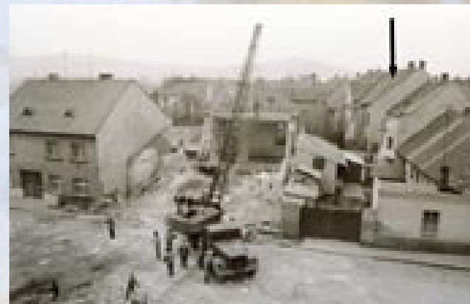
6. Demolice přeštické synagogy a evangelického chrámu v březnu 1974. Šipka označuje původně rabínský dům, od roku 1948 evangelická fara čp. 119 v Červenkové ulici. I ten brzy ustoupí nové výstavbě. Foto Ing. Jiří Běl
