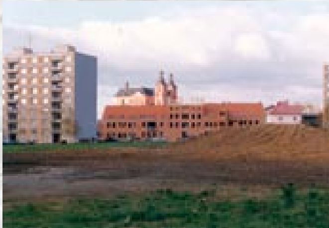
Staví se severní strana náměstí.
