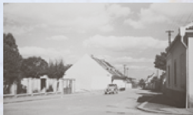
5. Poválečný fotograf stojí na rohu Červenkovy a Husovy a poskytuje nám dosti vzácnou podívanou na zaniklou zástavbu v západní části Husovy ulice. Vlevo ústí Vrchlického ulice a domy č. p. 385 a 384 (dnes paneláky č. p. 983–984) a následující (zcela vlevo plot areálu bývalého hejtmanství č. p. 465). Vpravo nárožní dům č. p. 118 (dnes prázdné nároží před lékárnou Magnolie).
