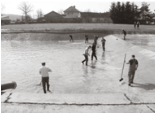
Čištění víceúčelové požární nádrže se provádělo mechanickou cestou.
