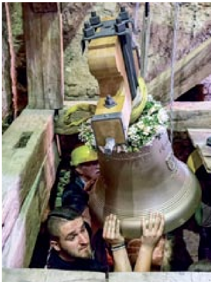
Pomocí silných paží byl 142 kg vážící a 70 cm vysoký zvon o spodním průměru 61,2 cm transportován do severní věže kostela. Foto Martina Kripnerová
