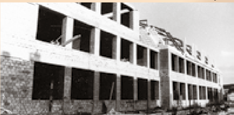
Na Jordáně, stavba budovy 30. 1. 1996.
