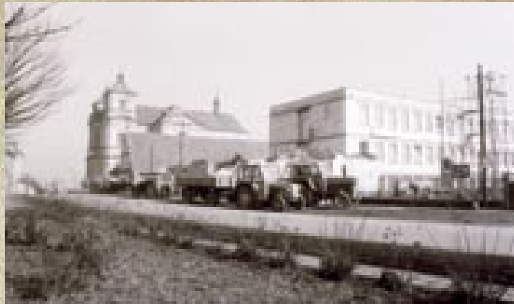
Stavba budovy JZD na Pohořku.
