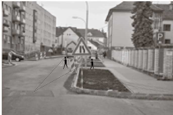
Po rekonstrukci. Bezpečnost především.
