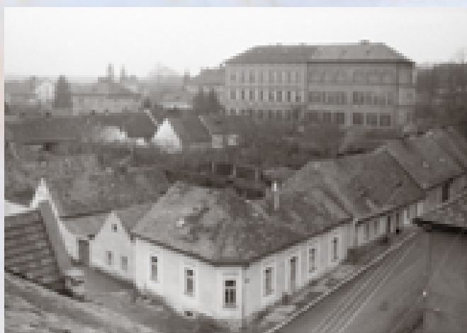
5. Pohled z podkroví hospodářské školy na nároží Husovy a Poděbradovy ulice. Nárožní dům č. p. 90 sloužil jako městská váha. Vlevo od něj č. p. 89 a 88. Dům městské váhy a celá fronta domů pod školou byly zbořeny v roce 1991 a vybudováno zde parkoviště, později lékárna a moderní bytové domy.
