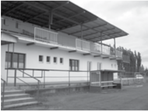
Kompletně dokončená zastřešená tribuna včetně technického a sociálního zázemí pro družstva na fotbalovém stadionu TJ Přeštice.
