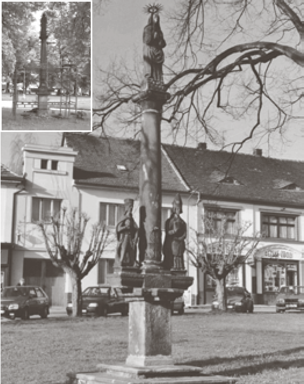
Velký snímek zachycuje Mariánský sloup před započatím restaurátorských prací, na malé fotografii je vidět průběh jeho oprav. 2x foto ing. Jiří Běl
