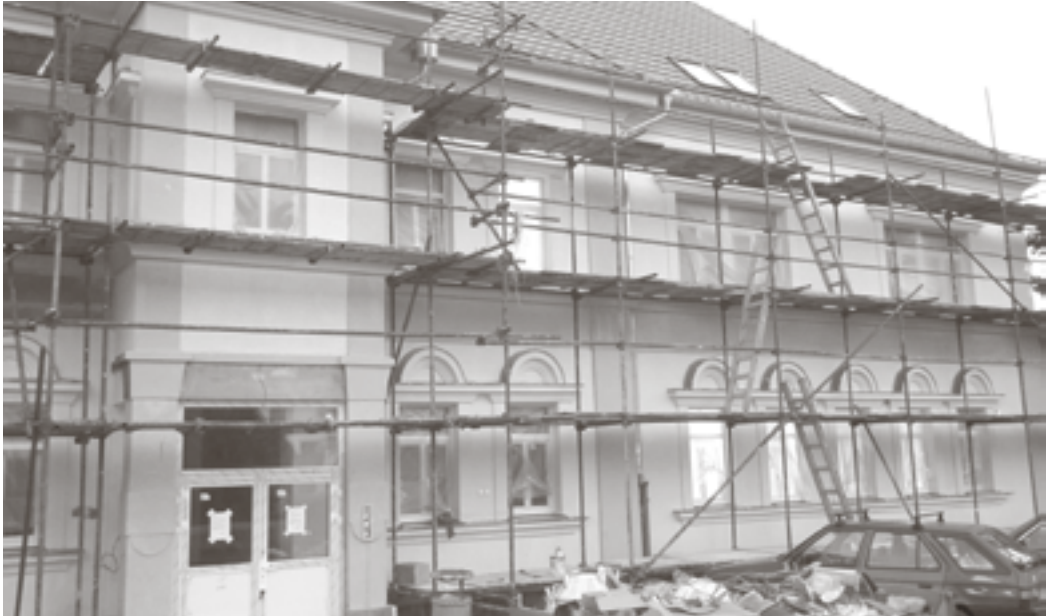
Budova bývalé „polikliniky“ v Sedláčkově ulici prochází v těchto dnech poslední etapou kompletní rekonstrukce. V interiéru budovy byly vyměněny rozvody elektroinstalace, odpadní a vodovodní rozvody, podlahy či okna a dveře. Budova doznala změn i zvenku, dostala novou krytinu, zateplení a fasáda novou barvu. Počátkem prosince se do budovy opět nastěhují odborní lékaři z provizorních prostor na Masarykově náměstí. (red)
