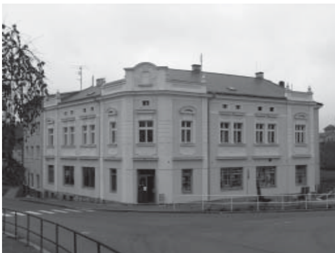
Fasáda domu čp. 100 "Na kopečku" dostala nový nátěr
