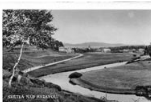
Na starých pohlednicích je dobře patrná levotočivá zatáčka silnice u prvních domů na okraji Světlé n. S. a nezregulovaný tok Sázkavy u Černého víru.
