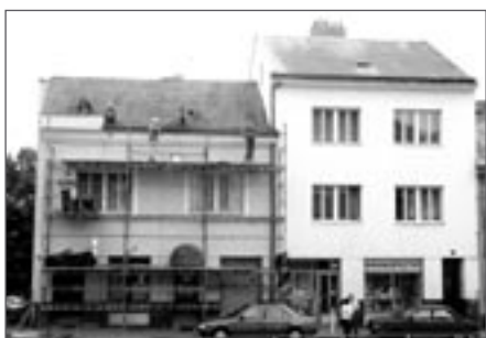
Oprava střechy na domě čp. 27
