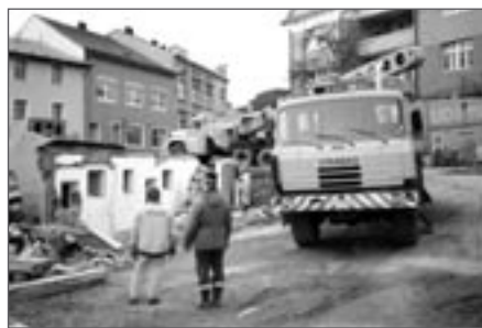
Bourání předmostí a veřejných WC
