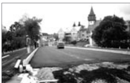
Pokládání živичné vrstvy
