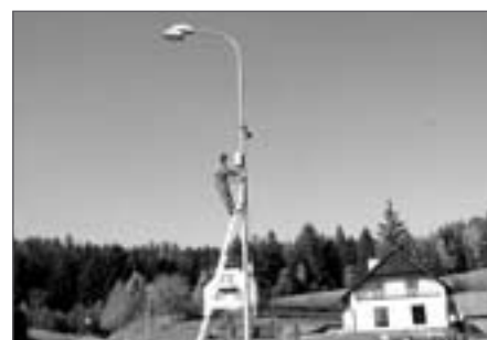
Montéři ve Vilémovicích (Foto: zř)
