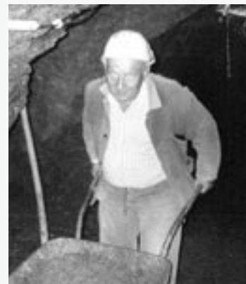
Při úpravách v podzemí
