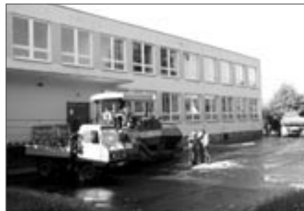
Pokládání nového asfaltového povrchu u ZŠ v Lánecké ul.
