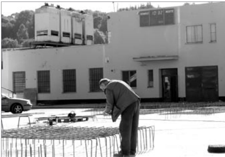
Digitální časomíra (v pozadí) újmu neutrpěla a čas na ní stále běží. Je to potvrzení toho, že zimní stadion v Humpolci ani po sesuvu střechy nepřestal žít
