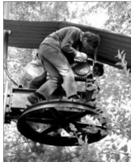
V. Špatenka s M. Majorem při montáži motoru na stožár vleku
