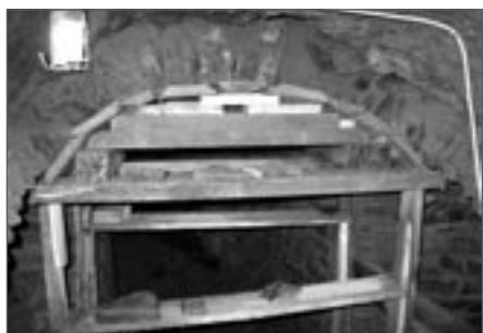
Ve středověkém podzemí pokračovaly práce na zajištění nestabilního úseku Foto: Jaroslav Vála
