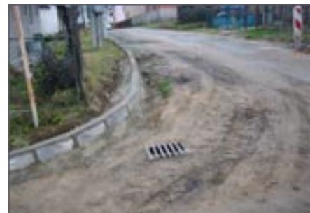
V březnu bylo provedeno osazení silničních obrubníků a úprava vpustí povrchové vody
