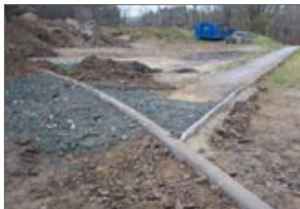
V březnu bylo provedeno osazení silničních obrubníků a úprava vpustí povrchové vody
