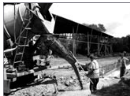
Stavbaři betonují základy budoucích šaten
