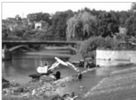
Dvěma snímky se vracíme k čištění koryta řeky Sázavy, které v létě provádělo Povodí Vltavy JV (foto: Jiří Višek)
