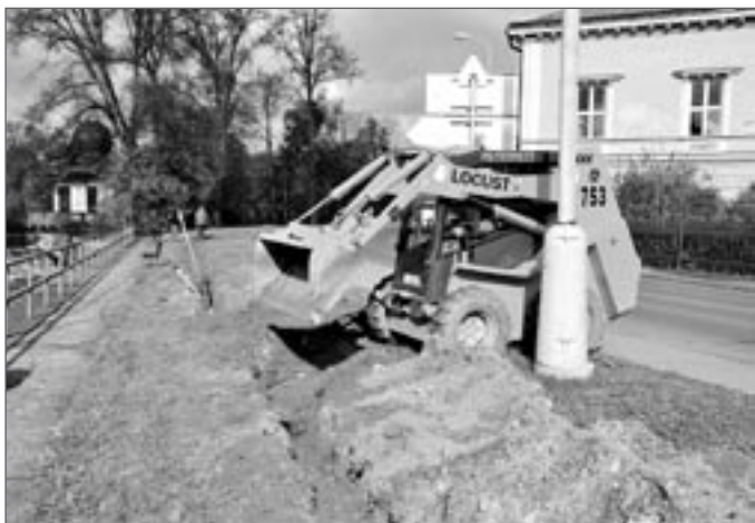
Pracovníci společnosti Wave-Net Světlá n. S., s. r. o., která poskytuje internetové připojení, pokládají optický kabel do rýhy na levém břehu Sázavy
