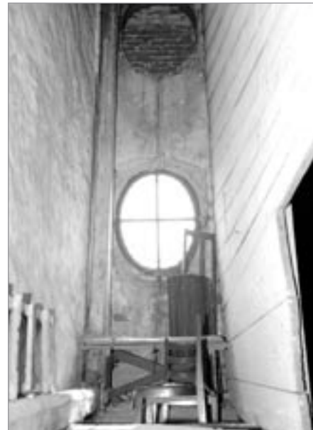
Pohled na okna v půdním prostoru severní boční lodi
