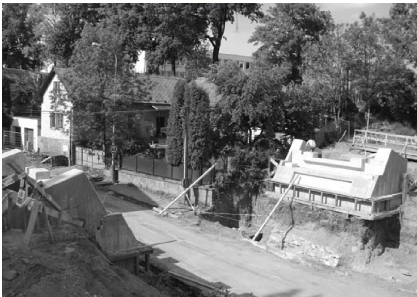
Rekonstrukce viaduktu v Lánecké ulici, stav 22. května (foto: Jiří Víšek)
