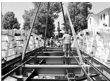
Usazování nového viaduktu
