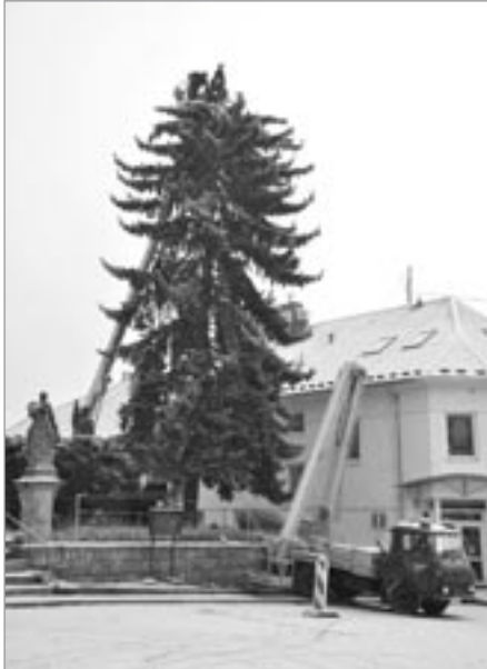
Za drobného sněžení instalovali pracovníci TBS Světlá n. S. osvětlení vánočního stromu před kostelem sv. Václava. -jv-
