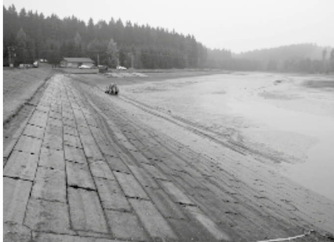
146 m dlouhá a 8 m vysoká hráz vodní nádrže Kristiánka
