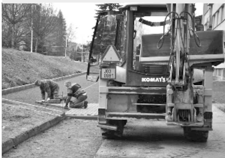
Pracovníci TBS pokládají zámkovou dlažbu
