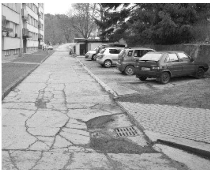
Komunikaci i parkoviště čeká rekonstrukce
