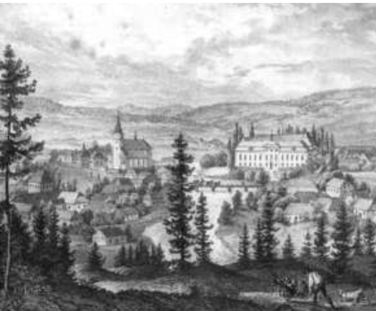
Zámek před rekonstrukcí
