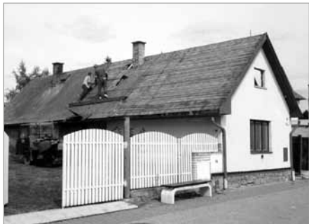
Začátek demolice domku 15. února 2005
