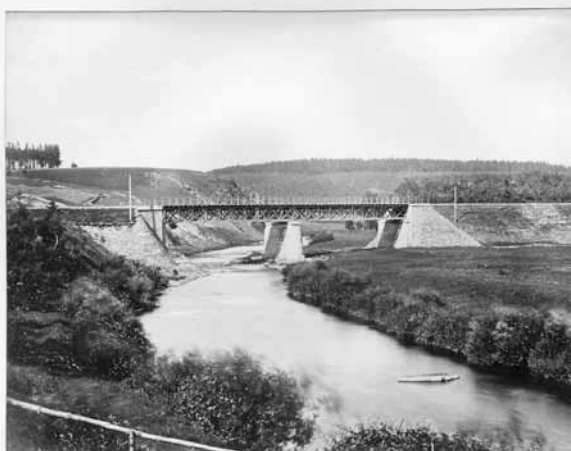
SAZAWA BRÜCKE BEI SWĚTLA
