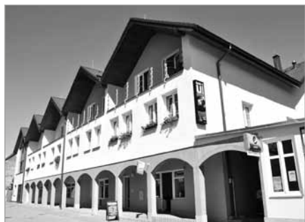
Nová výstavba na místě čp. 64 a čp. 120
