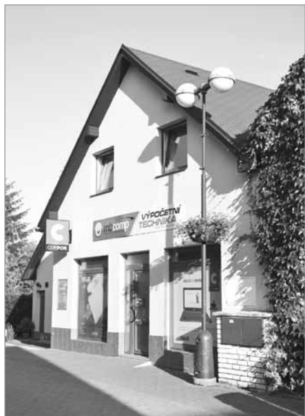
Přístavba domu čp. 82 na místě zbouraného domu čp. 81
