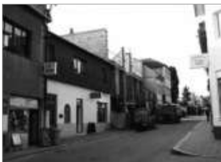
Stavba domu v roce 2001
