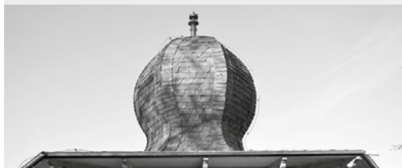
Detail kulovité části střechy s nově položenou břidlicovou krytinou
