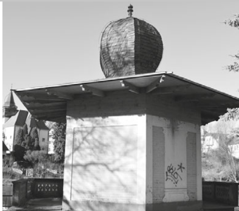
Celkový pohled na altán s rekonstruovanou střechou
