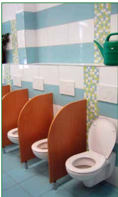
Rekonstrukce hygienického zázemí MŠ Na Sídlišti
