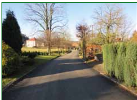
Oprava místní komunikace Radostovice
