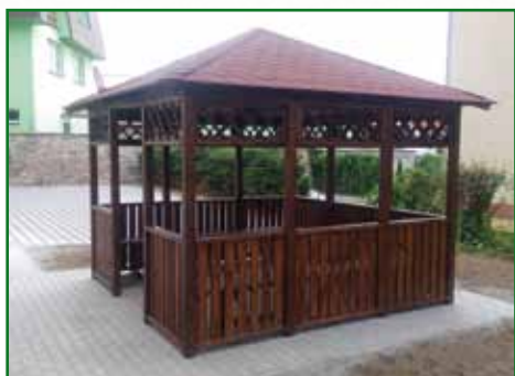
ZUŠ Světlá nad Sázavou, zahradní altán a zpevněná plocha
