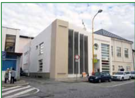
Rekonstrukce fasády domu č. p. 986, náměstí Trčků z Lípy
