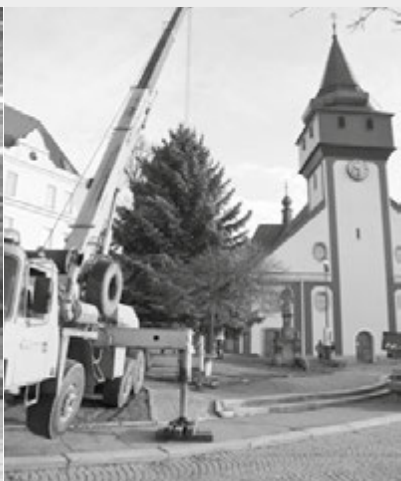
Hotovo, strom je usazen na svém místě
