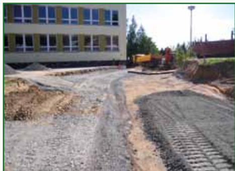
Rekonstrukce ulice Školní – průběh prací
