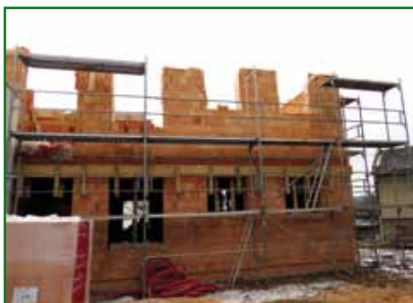
Novostavba pavilonu MŠ Lánecká
