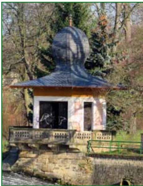
Obnova a zprovoznění Tureckého pavilonu – I. etapa
