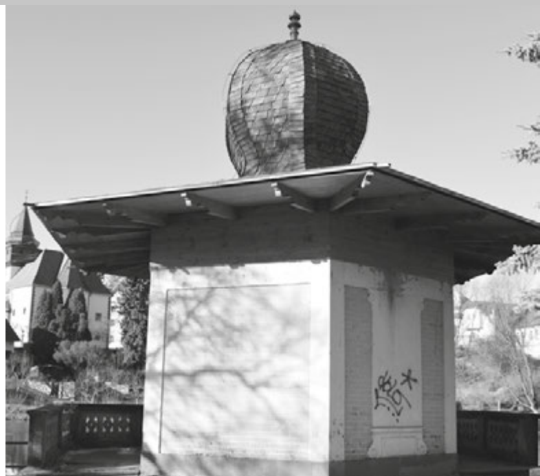
Celkový pohled na altán s rekonstruovanou střechou
