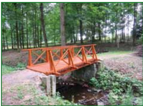
Oprava dřevěného mostku v parku
