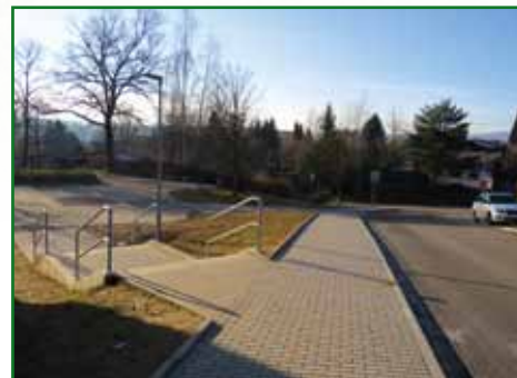
Rekonstrukce ulice Školní
