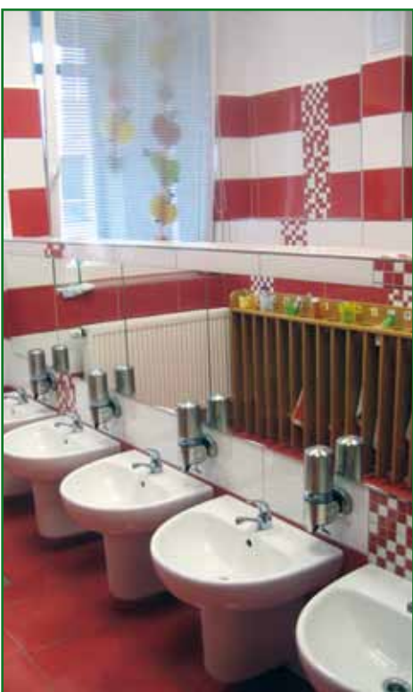
Rekonstrukce hygienického zázemí MŠ Na Sídlišti
