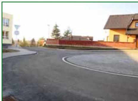
Rekonstrukce ulice Školní
