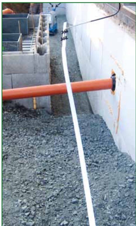
Odvlhčení stravovacího objektu v ZŠ Lánecká – průběh prací
