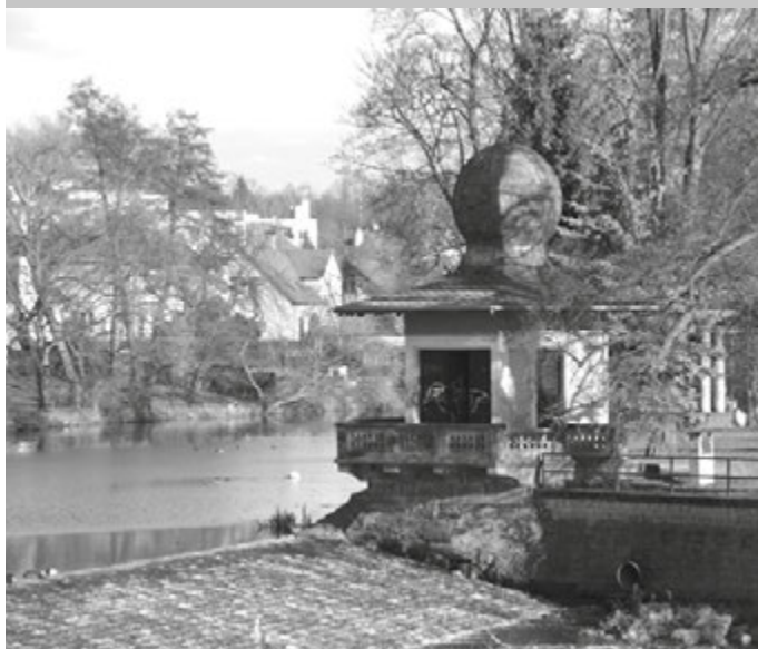
Současná podoba altánu při pohledu z mostu
