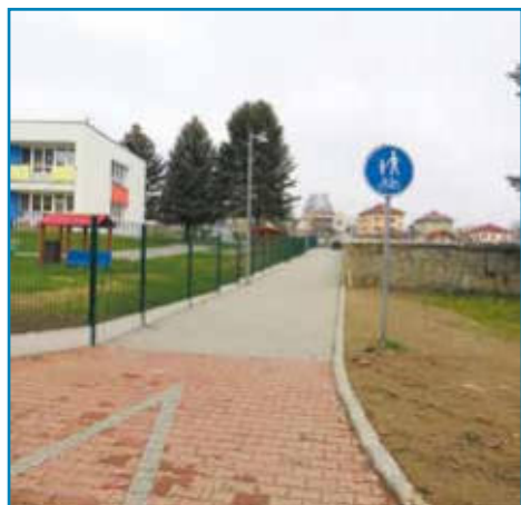
Stavební úpravy chodníku na pozemku parc.č. 794/2, k.ú. Světlá nad Sázavou
