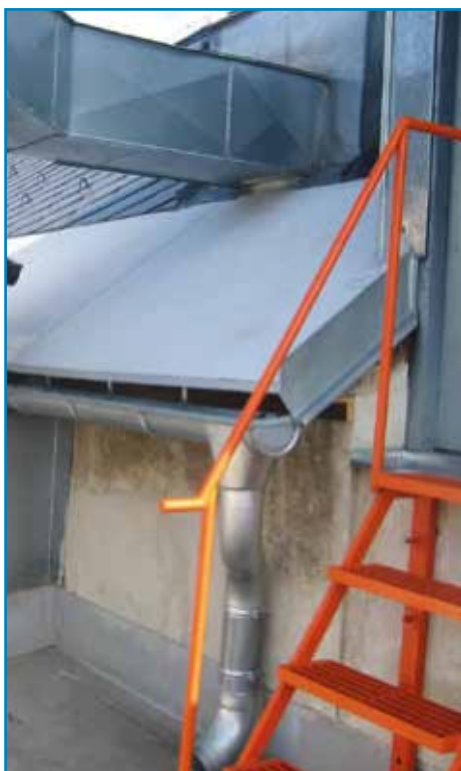
Oprava mezistřešního žlabu
