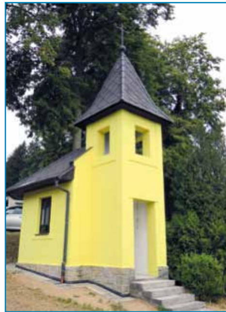
Oprava kapliček v místních částech, Žebrákov
