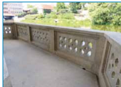
Obnova a zprovoznění Tureckého pavilonu, II. etapa
