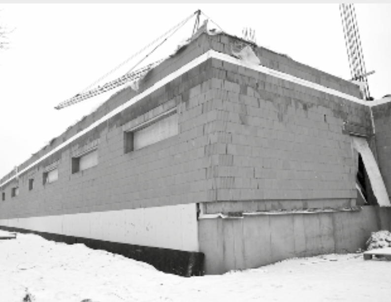
Hrubá stavba objektu zázemí haly
