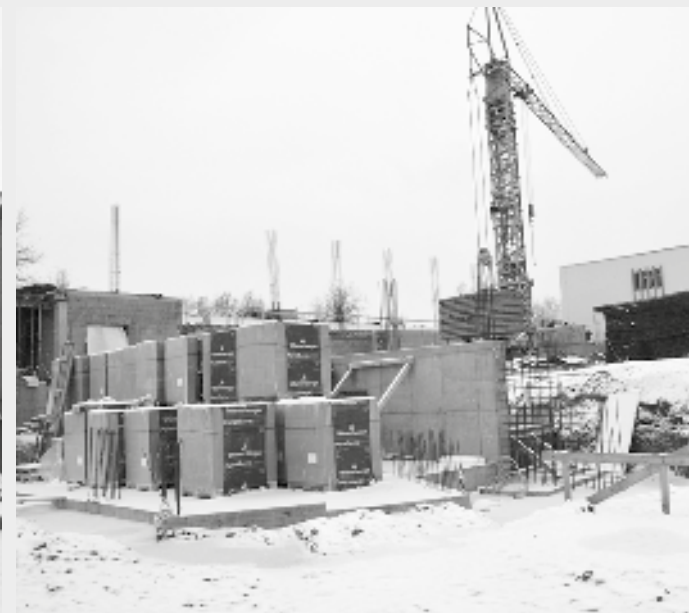
Pohled na staveniště ze směru od ulice Komenského
