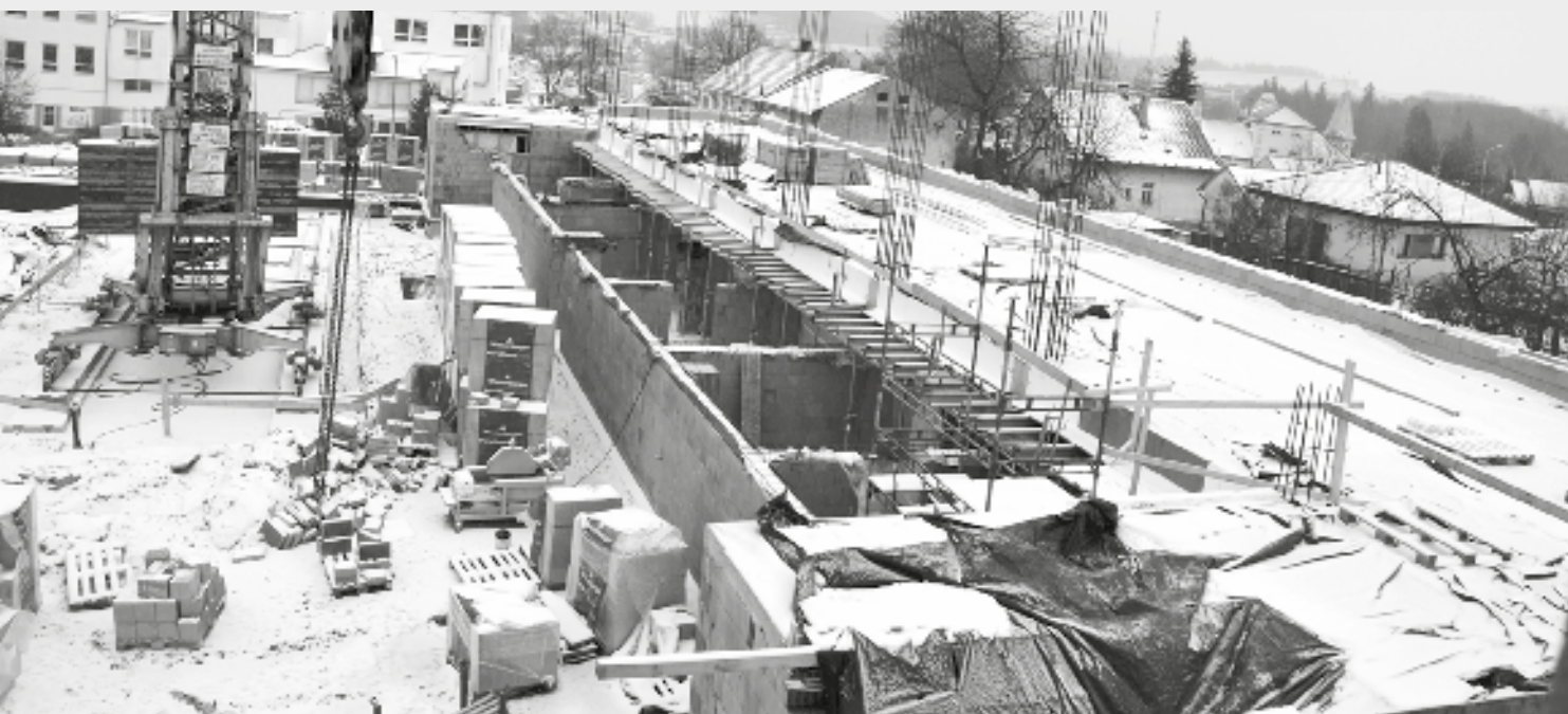
Celkový pohled na staveniště
