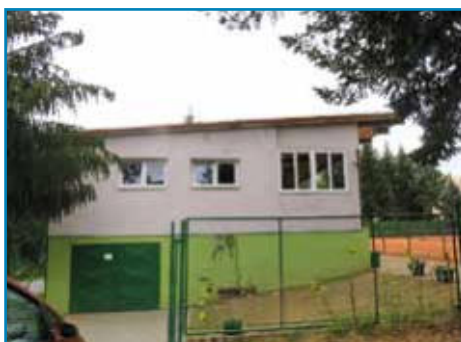
Stavební úpravy a přípojka vody, Tenisový klub Sklo Bohemia
