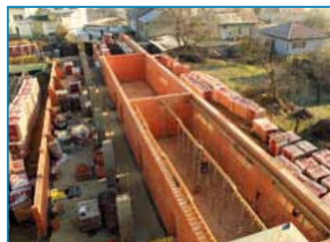
Sportovní hala Světlá n. S., novostavba
