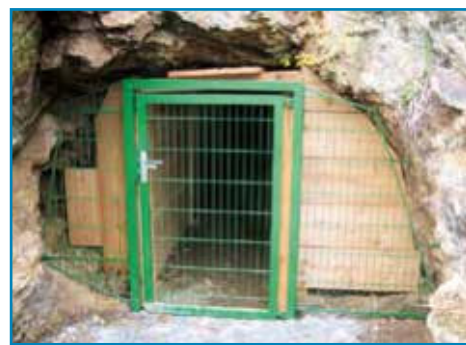
Oprava výdřevy v podzemí
