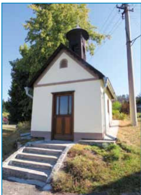
Oprava kapliček v místních částech, Leštinka
