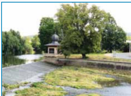
Obnova a zprovoznění Tureckého pavilonu, II. etapa
