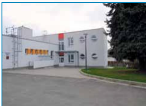
Novostavba pavilonu MŠ Lánecká
