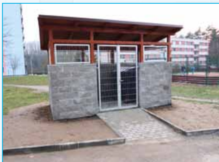
Přístřešky na odpadové kontejnery a plocha pro kontejnery tříděného odpadu
