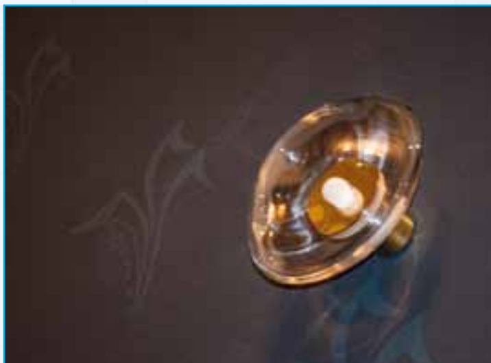
Akustické úpravy stěn a nástěnná svítidla v kinosálu
