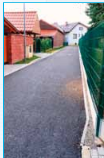
Rekonstrukce povrchu účelové komunikace, ulice Školní
