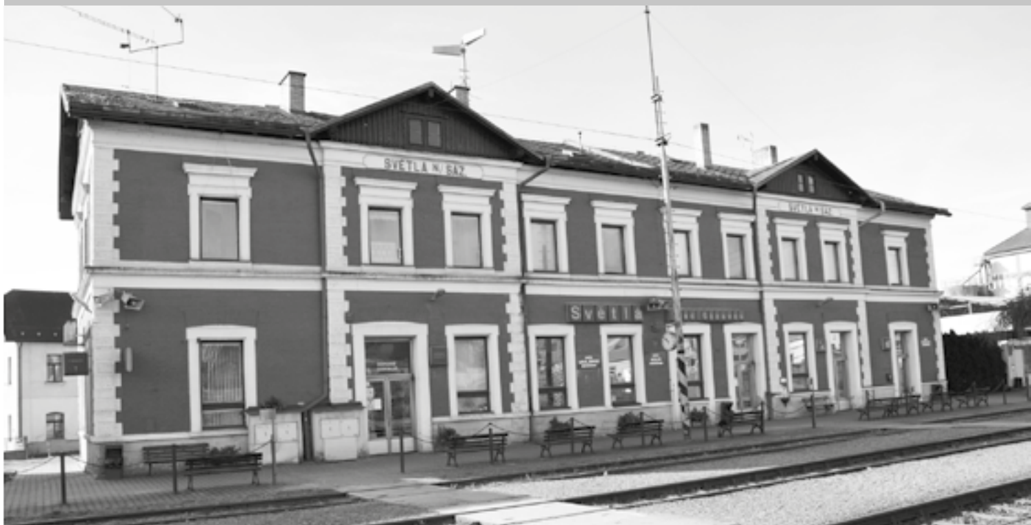
Pohled na historickou výpravní budovu od kolejiště
