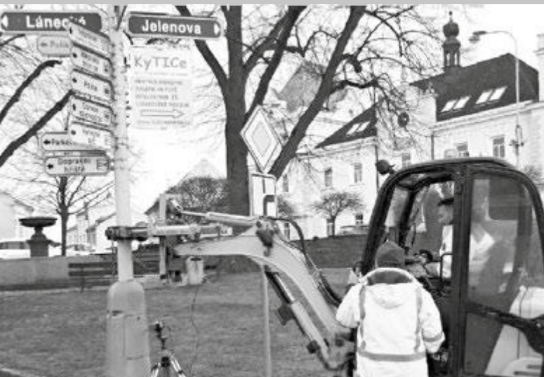
Test stožáru veřejného osvětlení a s informačními ukazateli...
