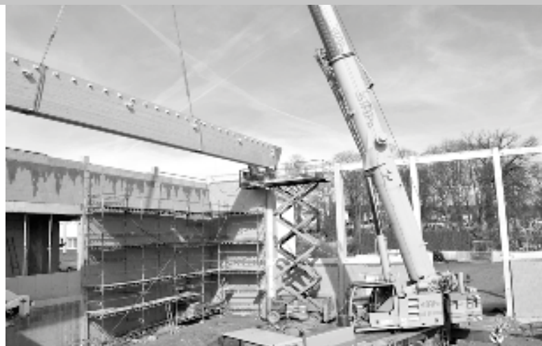
Historický moment stavby sportovní haly, kterým bylo položení prvních dvou vazníků střechy
